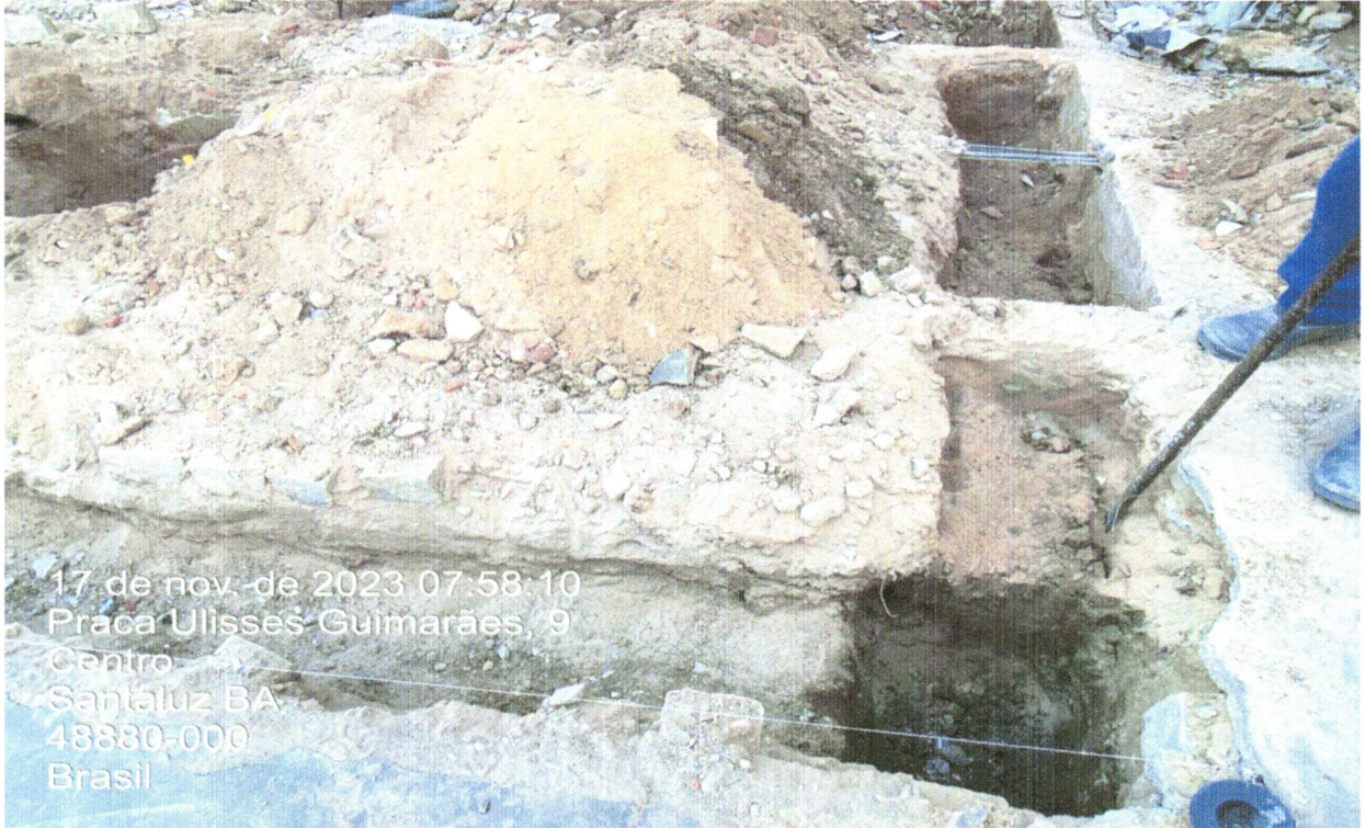
FOTO 14 - ESCAVAÇÃO MECANIZADA PARA VIGA BALDRAME COM MINI-ESCAVADEIRA (INCLUINDO ESCAVAÇÃO PARA COLOCAÇÃO DE FÔRMAS). AF_06/2017
