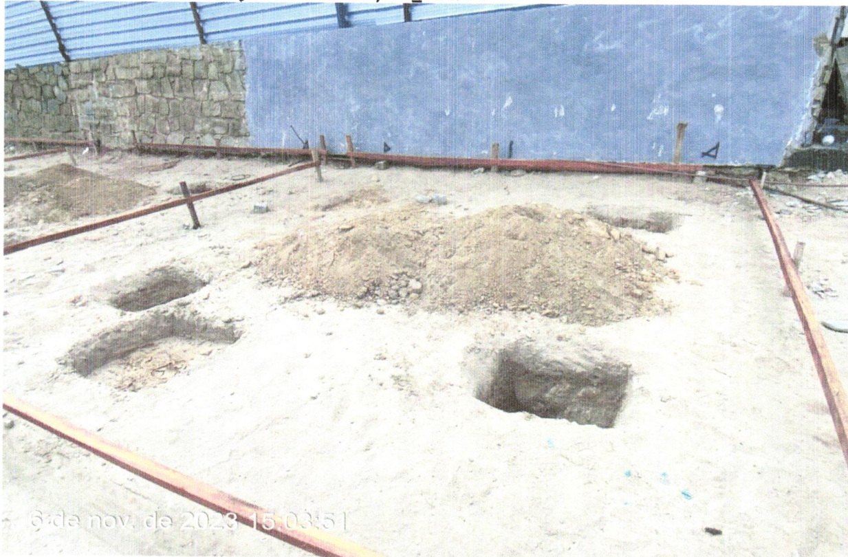
FOTO 50 - ESCAVAÇÃO MECANIZADA PARA VIGA BALDRAME COM MINI-ESCAVADEIRA (INCLUINDO ESCAVAÇÃO PARA COLOCAÇÃO DE FÔRMAS). AF_06/2017.
