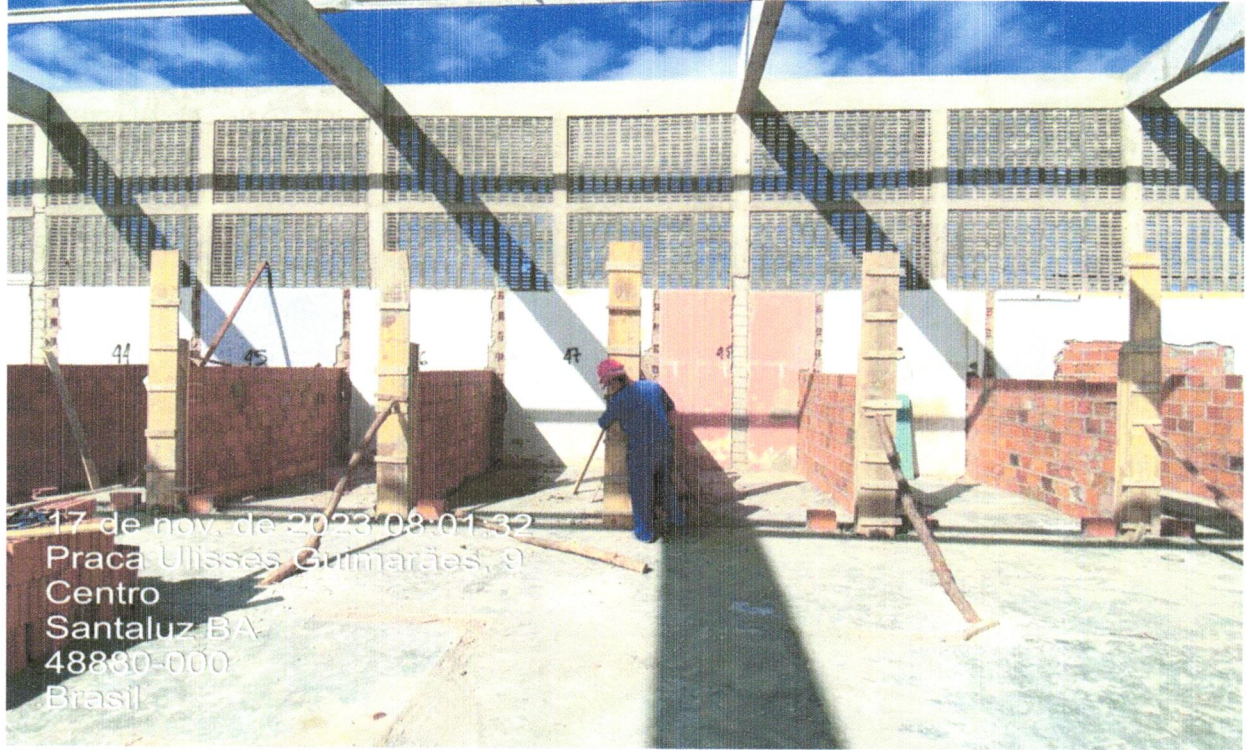
FOTO 18 - (COMPOSIÇÃO REPRESENTATIVA) EXECUÇÃO DE ESTRUTURAS DE CONCRETO ARMADO, PARA EDIFICAÇÃO INSTITUCIONAL TÉRREA, FCK = 25 MPA. AF_01/2017
