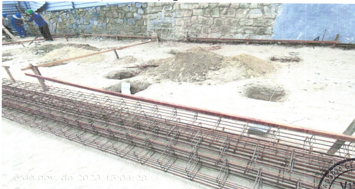
FOTO 50 - ESCAVAÇÃO MECANIZADA PARA VIGA BALDRAME COM MINI-ESCAVADEIRA (INCLUINDO ESCAVAÇÃO PARA COLOCAÇÃO DE FÔRMAS). AF_06/2017.
