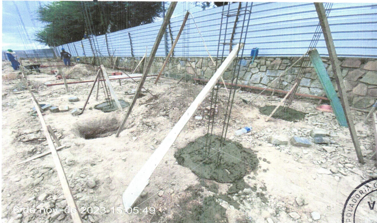
FOTO 52 - LASTRO DE CONCRETO MAGRO, APLICADO EM BLOCOS DE COROAMENTO OU SAPATAS, ESPESSURA DE 3 CM. AF_08/2017.
