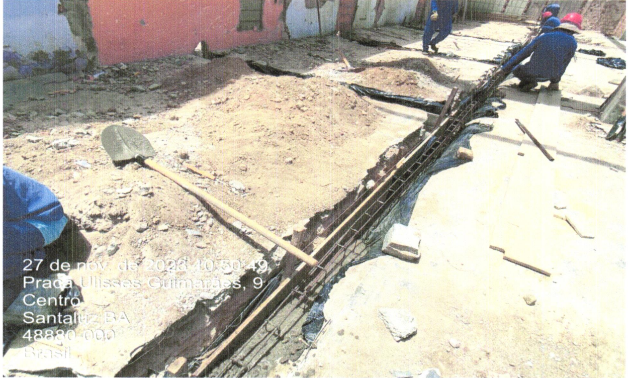
FOTO 16 - LASTRO DE CONCRETO MAGRO, APLICADO EM BLOCOS DE COROAMENTO OU SAPATAS, ESPESSURA DE 3 CM. AF_08/2017
