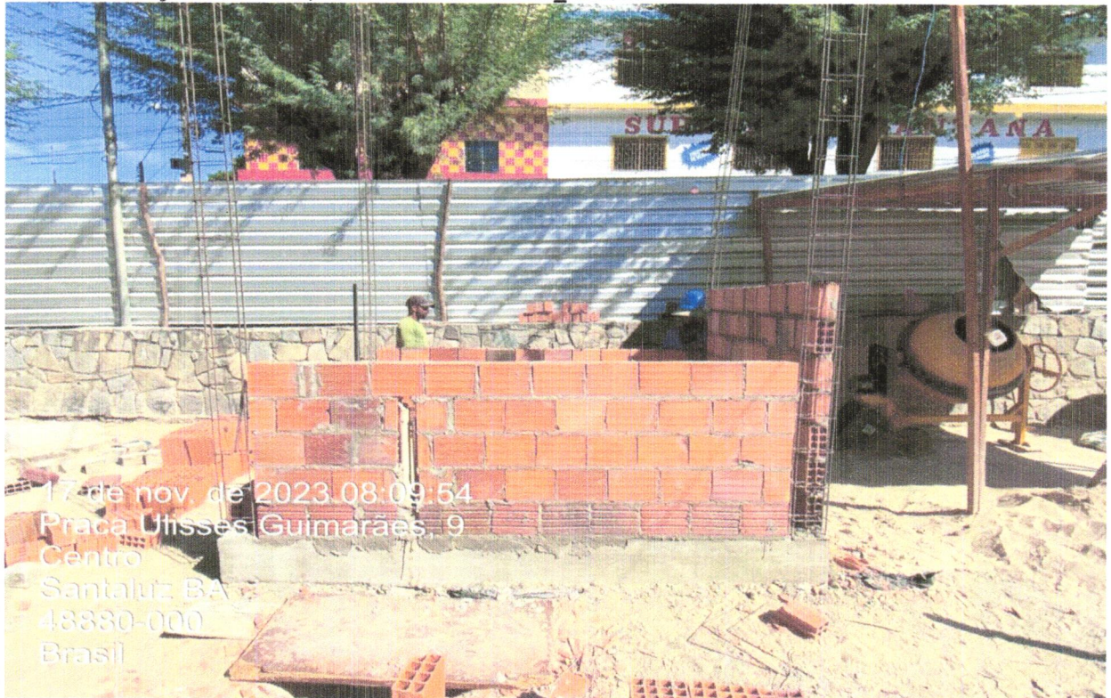
FOTO 56 - ARMAÇÃO DE PILAR OU VIGA DE ESTRUTURA CONVENCIONAL DE CONCRETO ARMADO UTILIZANDO AÇO CA-50 DE 8,0 MM - MONTAGEM. AF_06/2022
