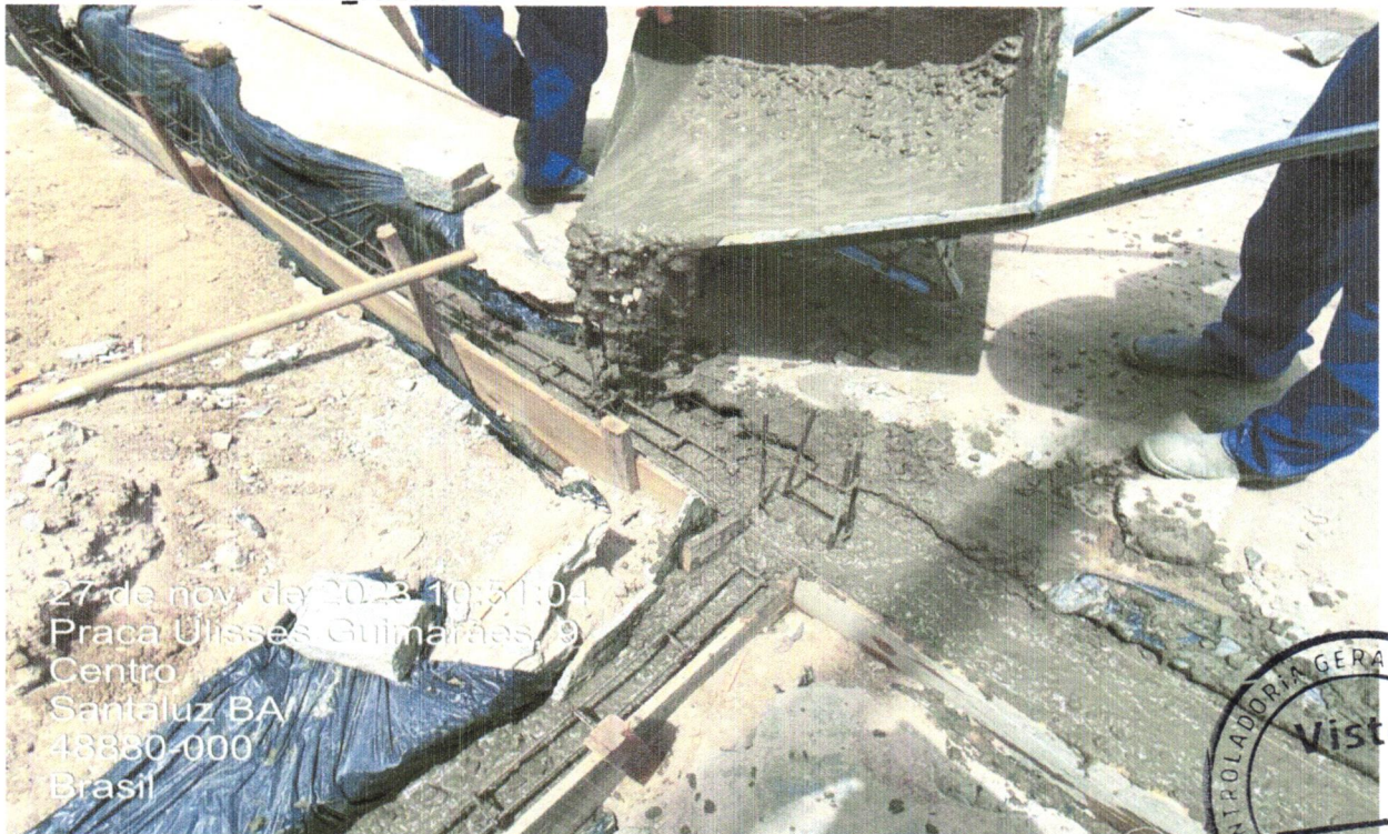
FOTO 16 - LASTRO DE CONCRETO MAGRO, APLICADO EM BLOCOS DE COROAMENTO OU SAPATAS, ESPESSURA DE 3 CM. AF_08/2017
