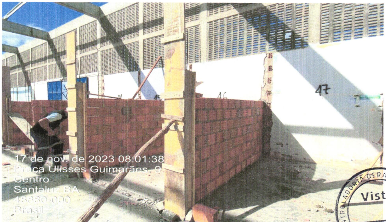
FOTO 18 - (COMPOSIÇÃO REPRESENTATIVA) EXECUÇÃO DE ESTRUTURAS DE CONCRETO ARMADO, PARA EDIFICAÇÃO INSTITUCIONAL TÉRREA, FCK = 25 MPA. AF_01/2017
